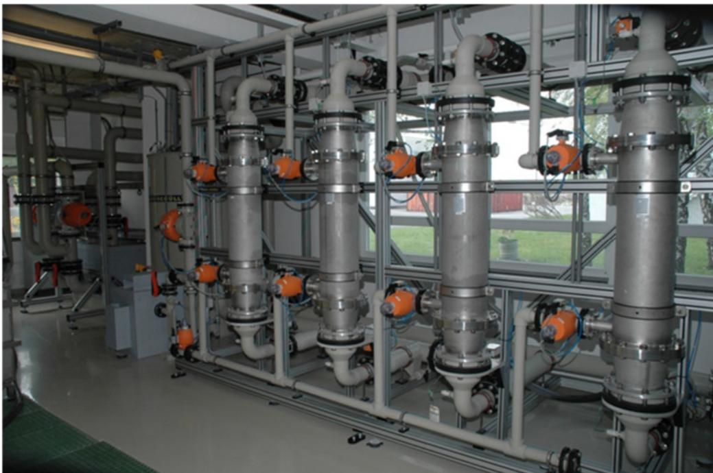
Abbildung 6: Filtriereinheit der Ultrafiltrationsanlage
