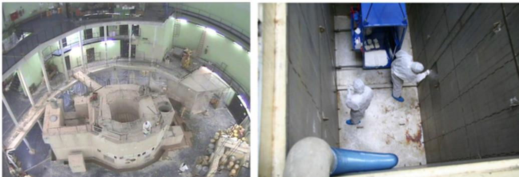
Abbildung 1: Rückbau des Forschungsreaktors ASTRA und des Brennelementlagerbeckens
